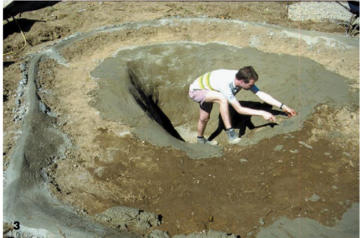
...und mit einer dünnen Betonschicht fixiert.
