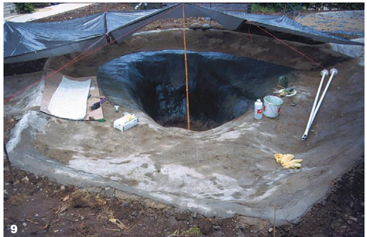
Zum Schutz vor direkter Sonnenbestrahlung wird die Arbeitsfläche beschattet.
