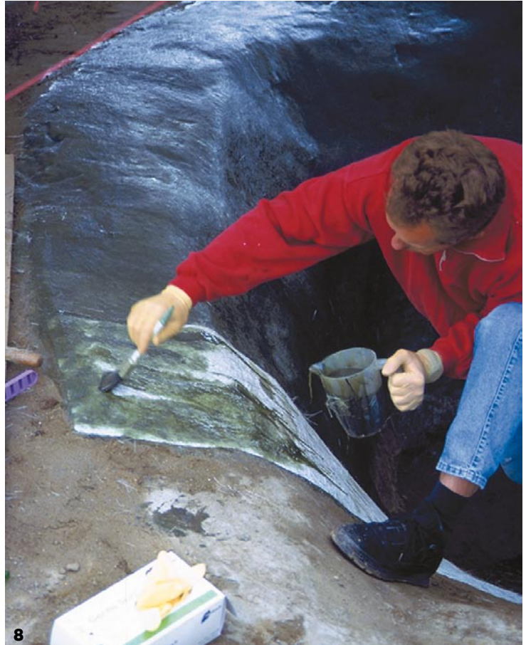
Auf dem ausgehärteten Beton werden die Glasfasermatten mit Polyesterharz getränkt und ausgerollt.
