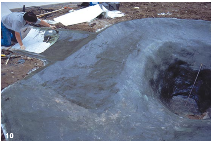
Die vorgegebene Form wird paßgenau mit Glasfaser belegt.
