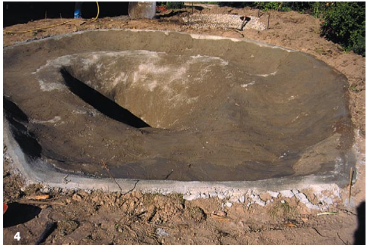
Die besondere Formgebung, seichte Uferzonen und ein steil abfallendes, tiefes Mittelteil, wäre mit Folie nicht zu realisieren.
