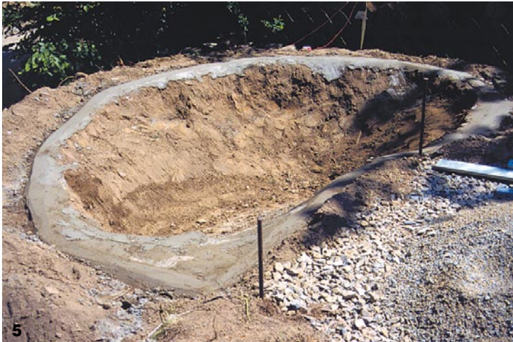
Bei diesem Projekt wurde ein Filterteich in der gleichen Weise angelegt ...
