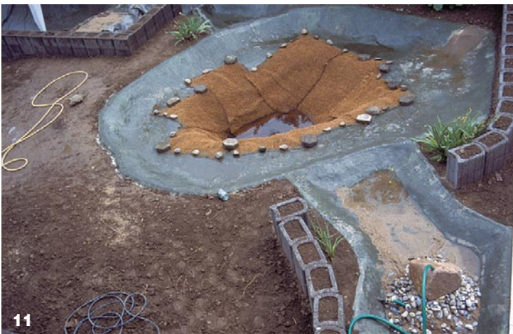
Nach dem Aushärten des Harzes wird der Teich eingerichtet. Hier wurden Böschungsmatten eingeklebt und der Sprudelstein eingebracht.
