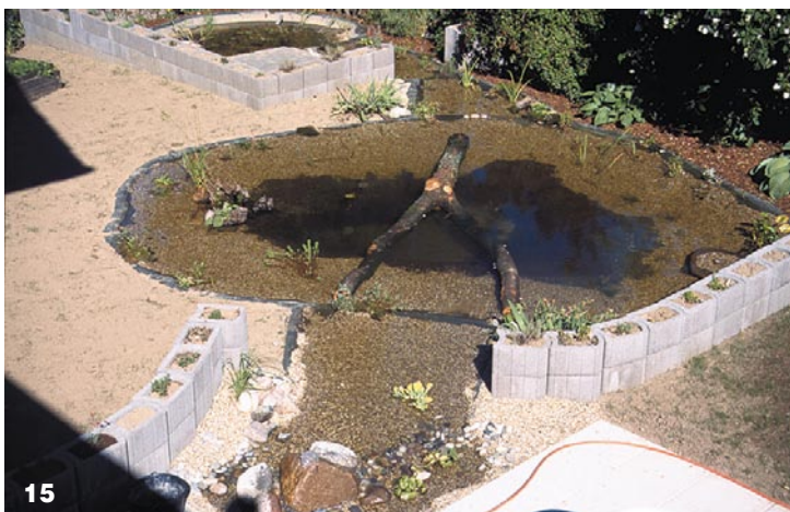
Die Teichanlage nach Einbringen von Kies, der ersten Bepflanzung und befüllen mit 13.000 L Wasser.
