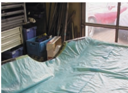
34 Einlegen der Lochfolie, anschließend wird eine Lage Saugvlies aufgelegt.
