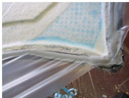
36 Beim Absaugen wird das Laminierharz durch die Lochfolie in das Saugvlies gepresst.
