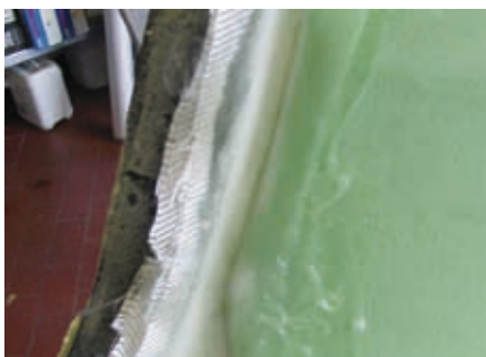
42 Der Rand wird mit Streifen von Glasgewebe 163g/m 2 vorlaminieren.
