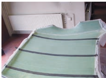
44 Die komplette Oberfläche wurde mit einer Lage Glasgewebe 163g/m 2 belegt. In Längsrichtung wurde einlagig UD-Kohleband eingelegt.
