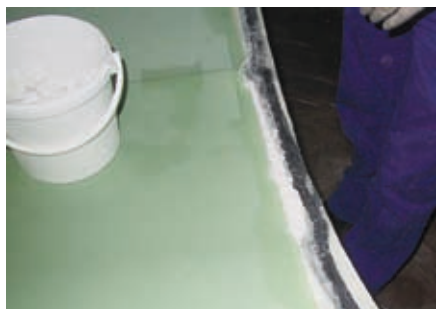
39 Auffüllen der Kanten mit Epoxidharz und Glass-Bubbles.
