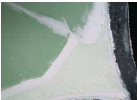
40 Der Rand läuft zum Decklaminat aus.
