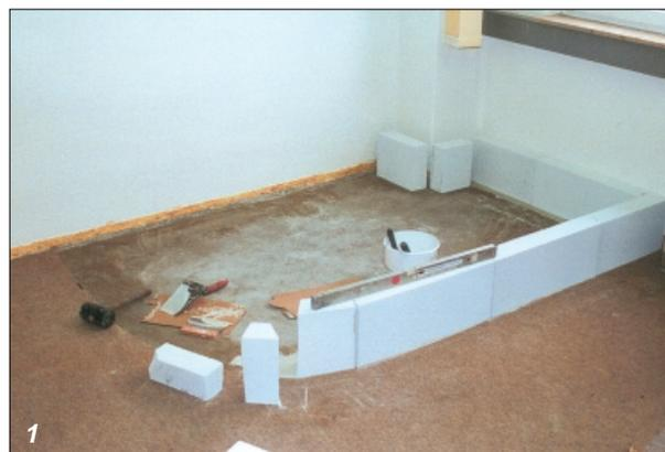
Die Abmessungen der Teichwanne werden aufgerissen und mit Ytong-Steinen aufgemauert.
