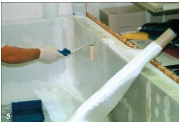
5 Von der Rolle wird das Glasgewebe für die Wand aufgebracht und mit Harz getränkt. Insgesamt werden 3 Lagen Glasgewebe  $163 \text{ g/m}^2$  aufgebracht, was einer Wandstärke von ca. 1 mm entspricht.
