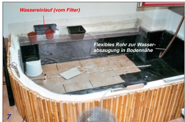
7 Nach der Aushärtung erfolgen die Feinarbeiten: hier wird noch ein Pflanzenfilter anlamiert. Das Wasser strömt zunächst durch den Pflanzenkasten, bevor es durch ein PVC-Rohr wieder zurück in den Teich geleitet wird.
