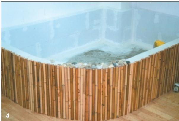
4 Nach Fertigstellung der äußeren Gestaltung wird zunächst der Boden laminiert.
