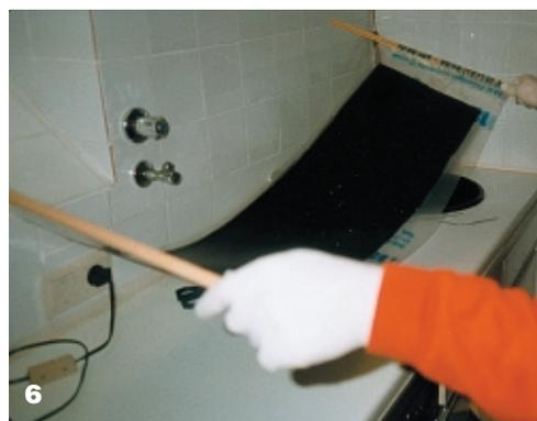
Bild 6: Die Folie dient als Tragehilfe für das vorgetränkte Gewebe. Das Gewebe kann optimal auf der Form plaziert werden, ohne daß sich einzelne Gewebebahnen verschieben.
