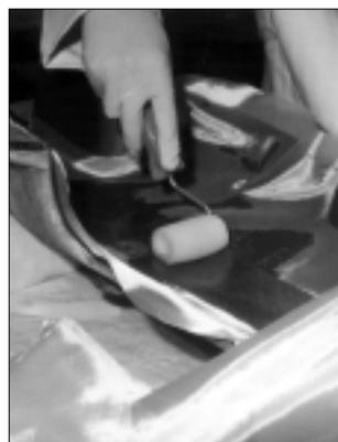
Herstellen eines Handlaminats mittels Schaumstoffwalze
