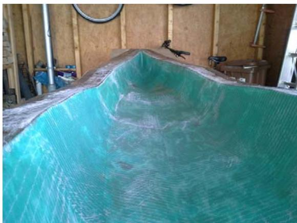
Abb. 7-21: Schleifen der Glasfaser
