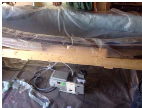
**Abb. 7-33: Anbringen der Vakuumtechnik**
