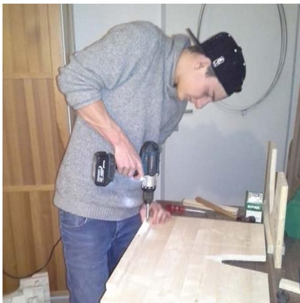
Abb. 7-6: Zusammenfügen der Spantenteile
