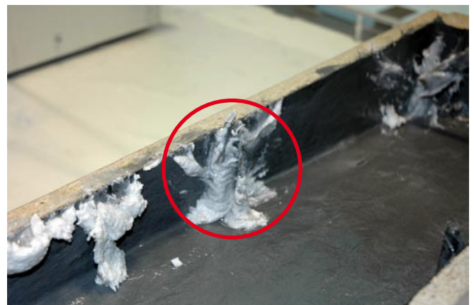
Hinterfüllung der Passstifte
