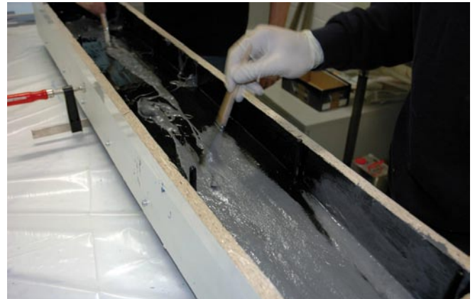
Auftragen der Kupplungsschicht
