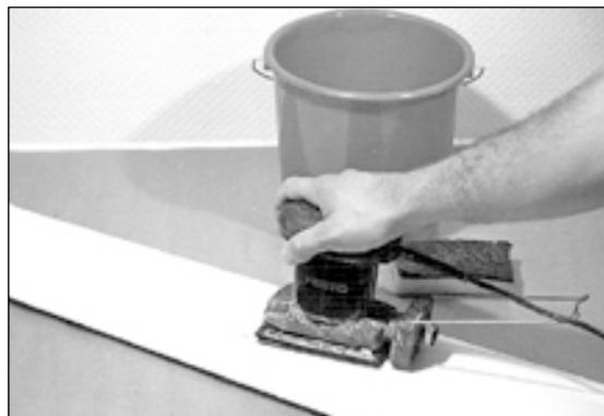
Geschliffen wird mit Schwingschleifer
